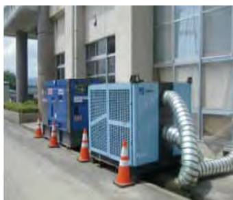
空調工事中の学校
