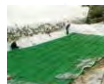
ダム放水口修繕工事
